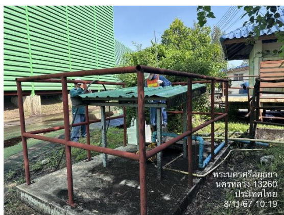
รูปที่ 2-7 บ่อตรวจคุณภาพน้ำทิ้ง ขนาดความจุ 5.67 ลบ.ม.
